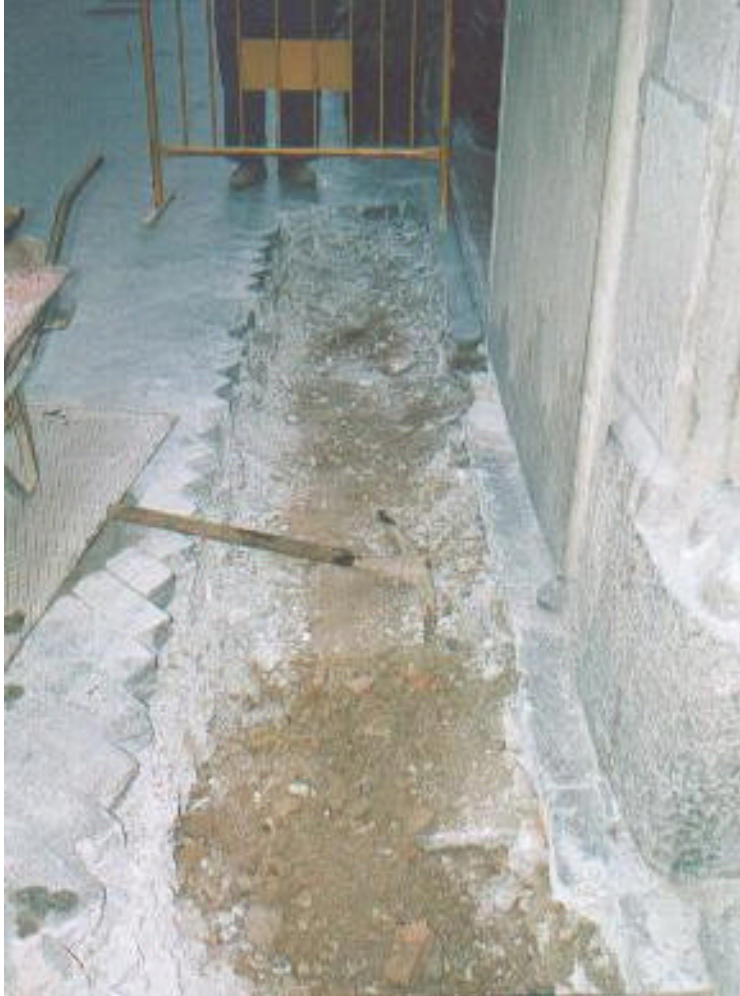
Fotografia. 1: Detall de la rasa 100 abans d' iniciar la seva excavació.
