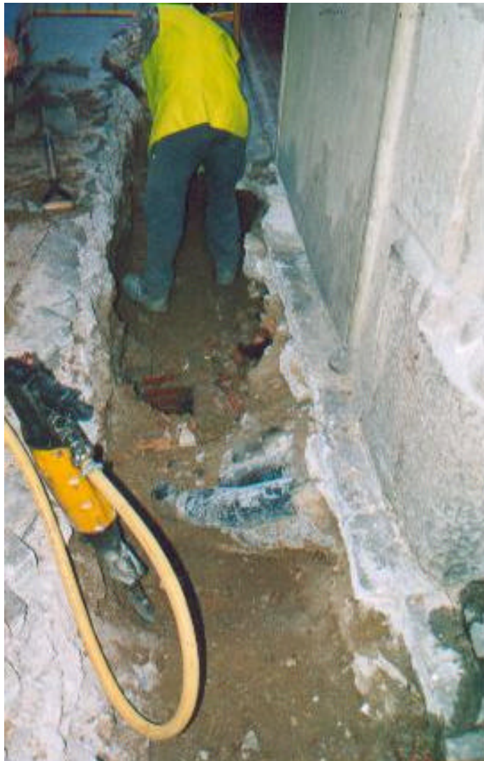
Fotografia. 2: Detall de la rasa 100 durant la seva excavació.
